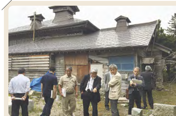
寿都町の橋本家（旧鎌御殿）の改修工事を監修しているメンバー
